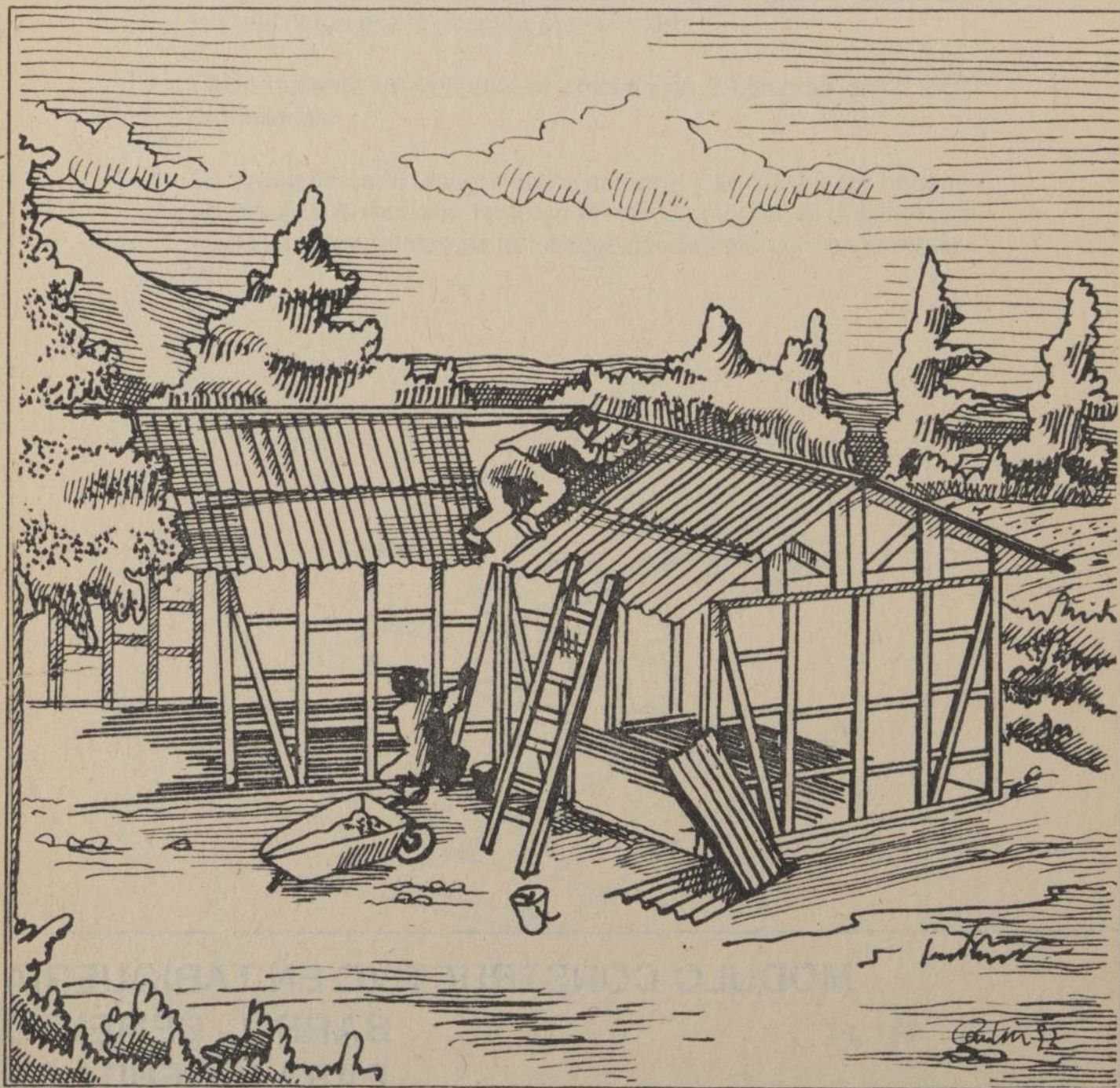
Módulo constructivo en tabiquería barro-cemento
