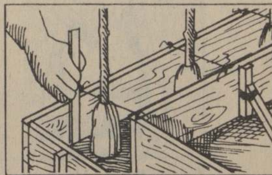
fig.24: Preparación de sobrecimientos.
