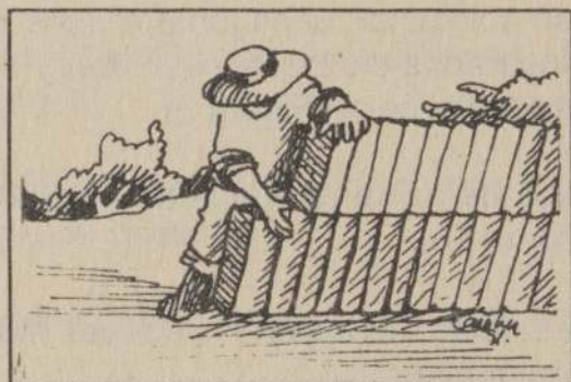
fig.11: Apilando adobes secos.
