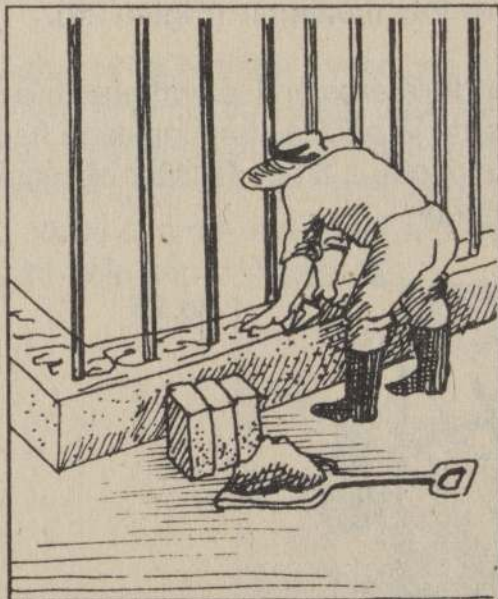
fig.28: Colocar una capa de mortero encima del sobrecimiento.
